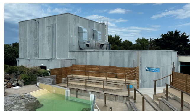
Depuis quelques mois, les visiteurs attentifs auront remarqué la construction d'un bâtiment à l'architecture futuriste.
